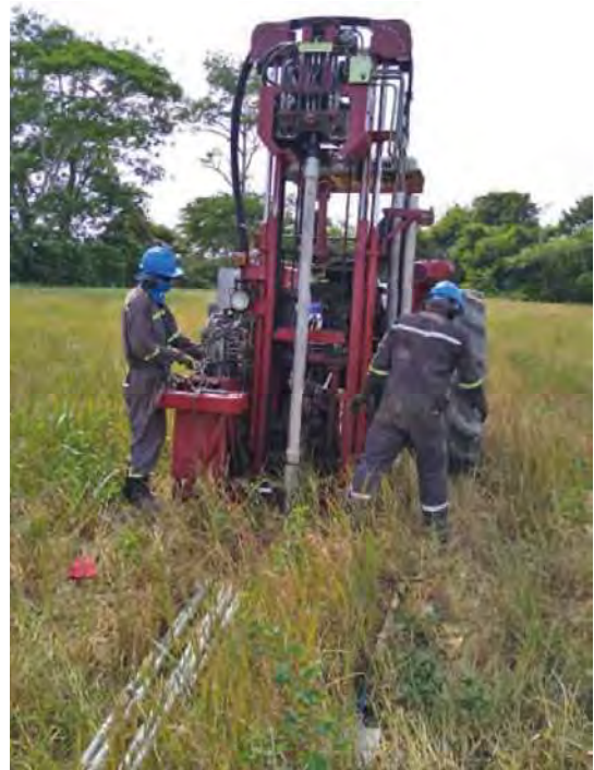
Figura 34. Taladro sónico siendo utilizado en los Llanos Orientales de Colombia. Esta tecnología es ideal para perforación en zonas de depósitos aluviales. Foto cortesía de Geofizika Torun.
